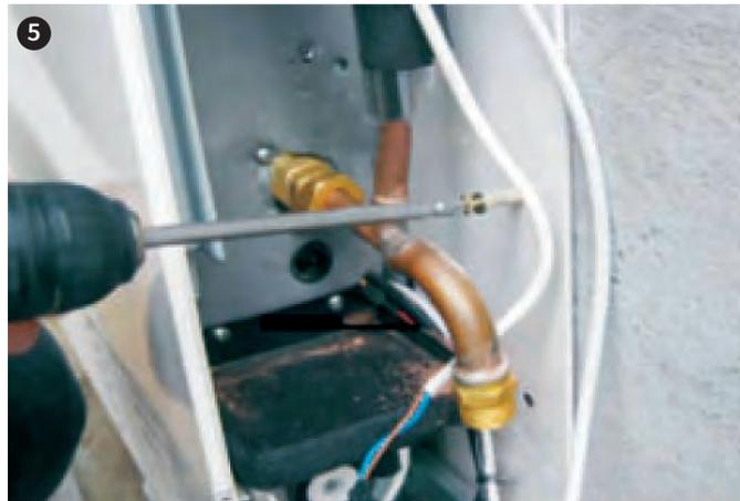
*Befestigen Sie das Gerät mit Schrauben.*
