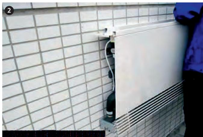
Montieren Sie das Gerät auf den Metall-Spreizbolzen.
