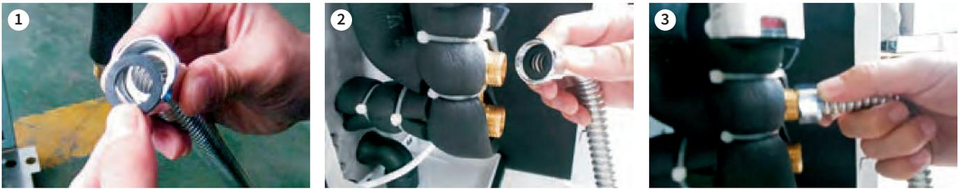
**ACHTUNG!** Zum Anschluss des Wasserzu- und -ablaufs des Geräts an die Wasserleitung muss ein Schraubenschlüssel verwendet werden, um den Anschluss am Gerät zu fixieren, während ein zweiter Schraubenschlüssel zum Festziehen der Rohrverbindung am Anschluss verwendet wird. Verwenden Sie für diesen Vorgang nicht nur einen Schraubenschlüssel, da dies zu einer Verdrehung und Beschädigung des Wasseranschlusses am Gerät führen kann.
