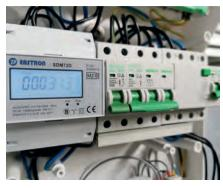
Ein elektrischer Energiezähler ermöglicht die Überwachung des Energieverbrauchs der Wärmepumpe.
