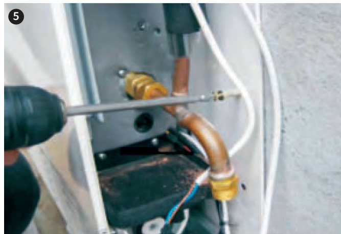
Zamocuj urządzenie za pomocą śrub.
