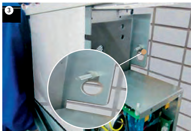
Zamocuj śruby rozporowe z każdej strony.
