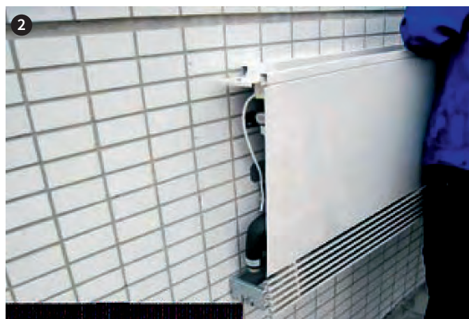
Zamocuj urządzenie na metalowych kołkach rozporowych.
